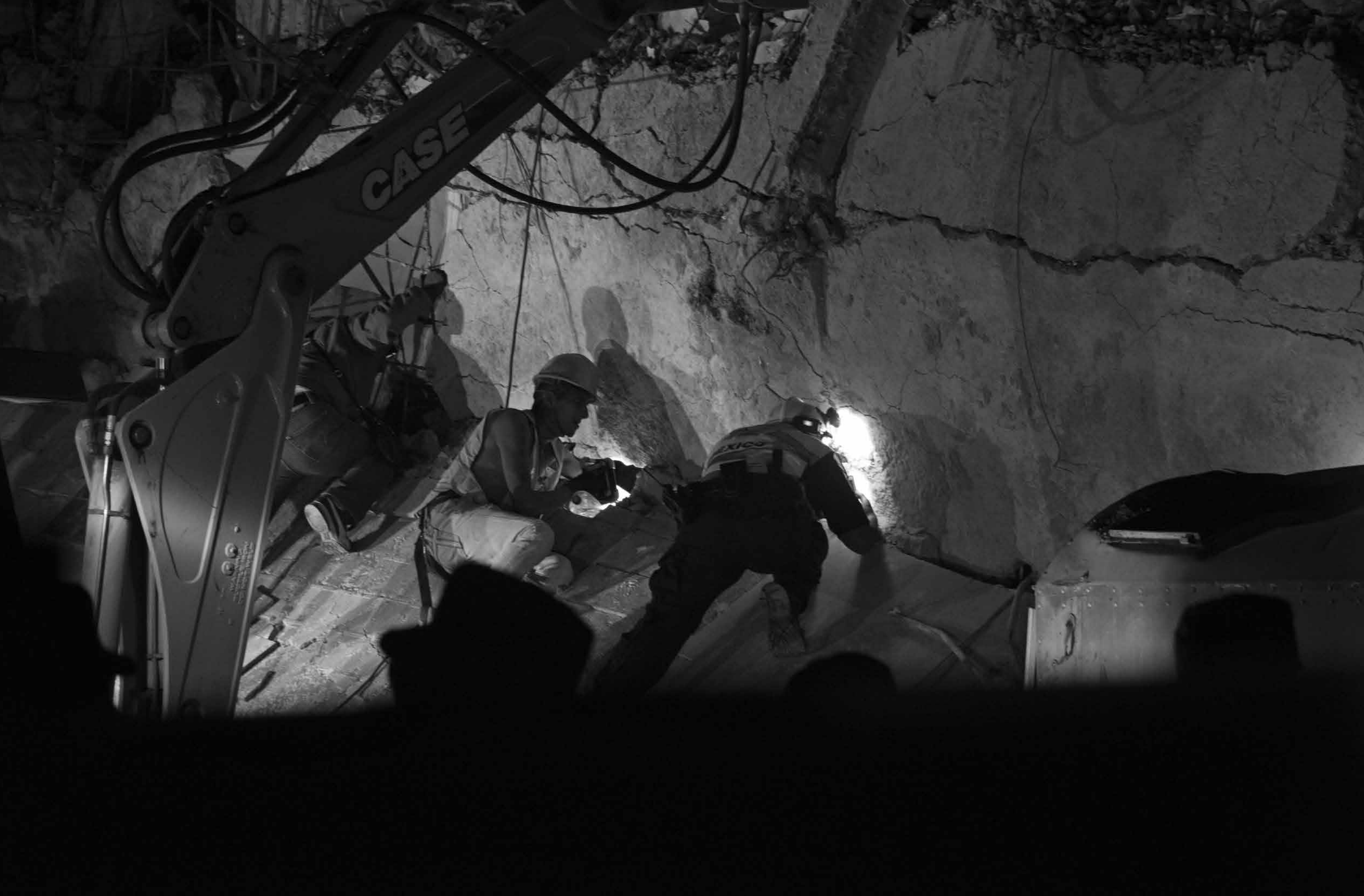
Dos rescatistas trabajan juntos la noche del 19 de septiembre para encontrar personas con vida entre los escombros de un edificio en la esquina de San Luis Potosí y Medellín. Colonia Roma, Ciudad de México, 19 de septiembre de 2017. Foto: Israel Fuguemann.
