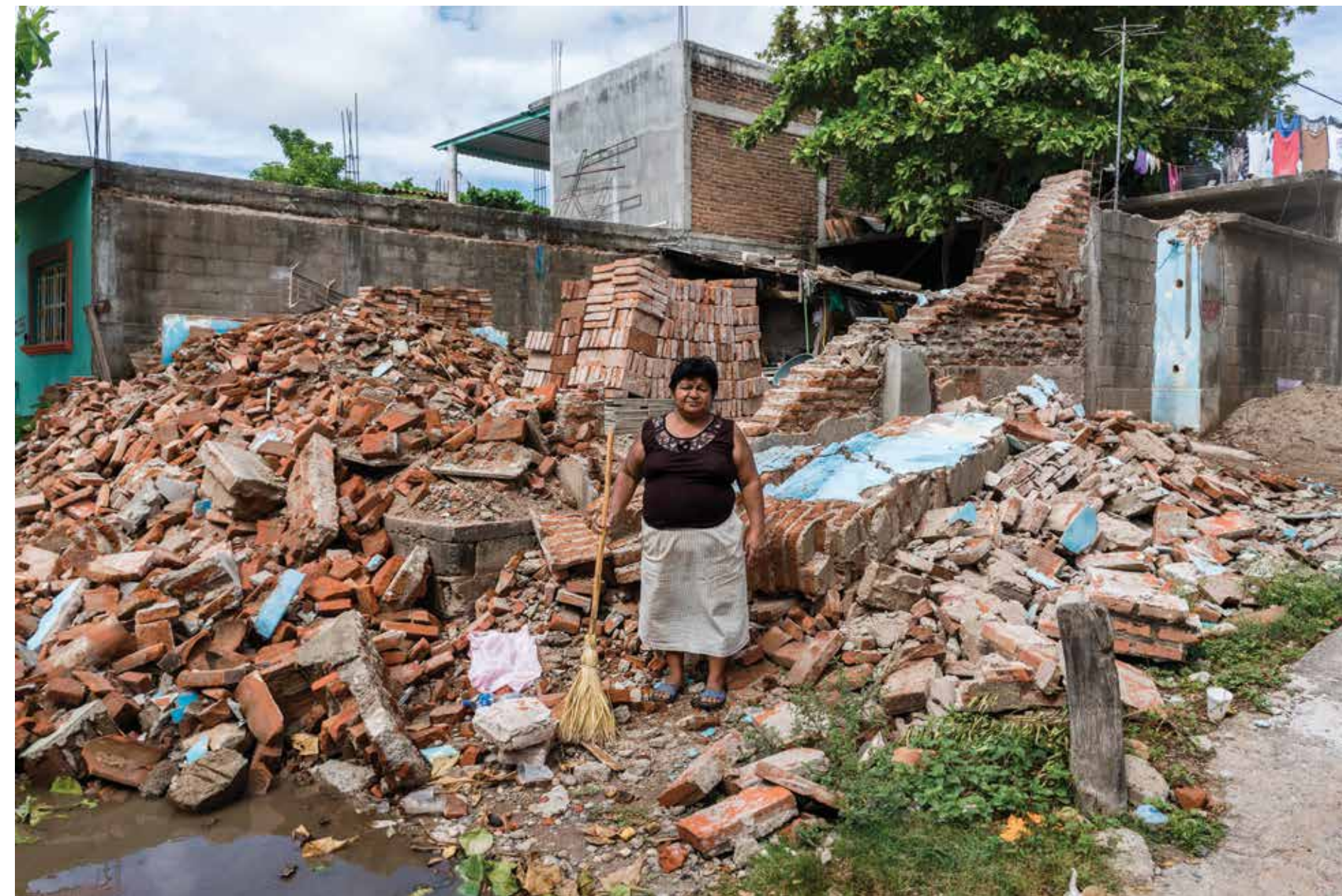
Señora posa con escoba luego de retirar escombros. Juchitán, Oaxaca, 16 de septiembre de 2017. Foto: Mauricio Alejandro Challu.
