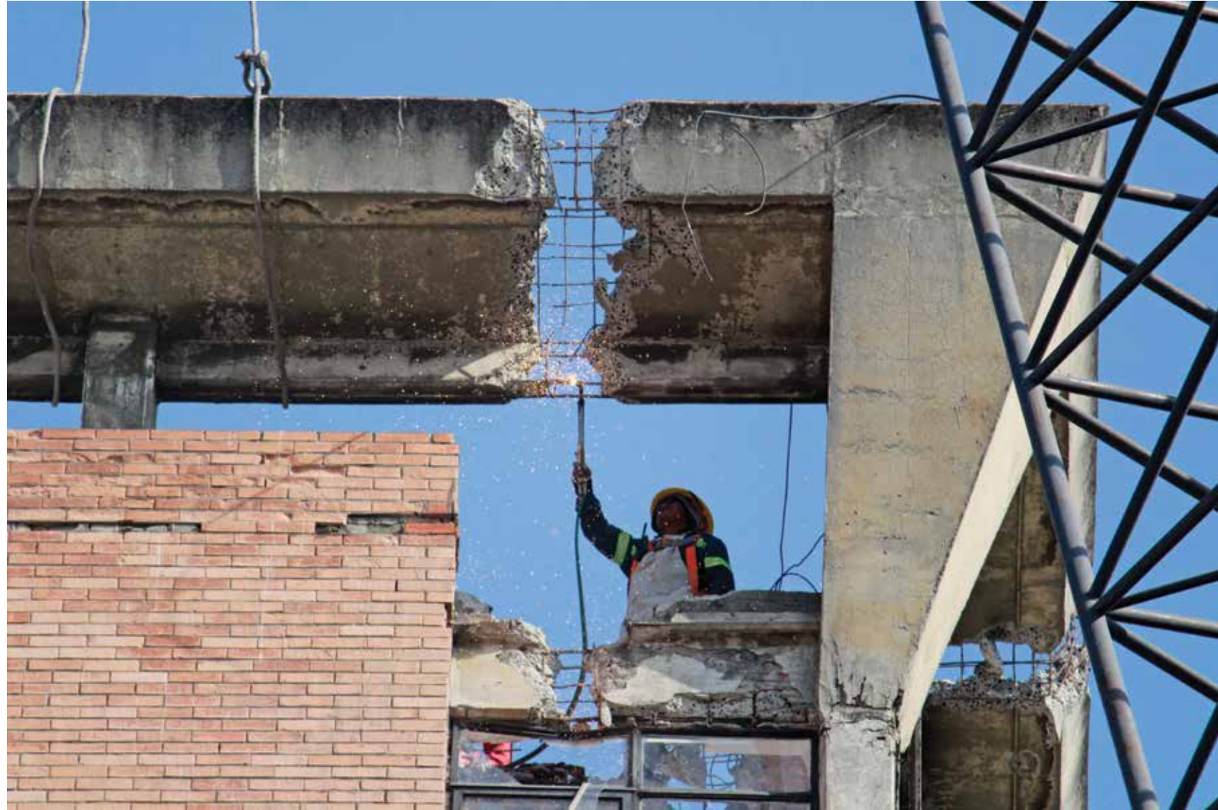
El Gobierno de la Ciudad de México trabaja en la demolición de un edificio en la esquina de Dr. Navarro y Dr. Lucio. Colonia Doctores, Ciudad de México. Foto: Rocío Díaz.
