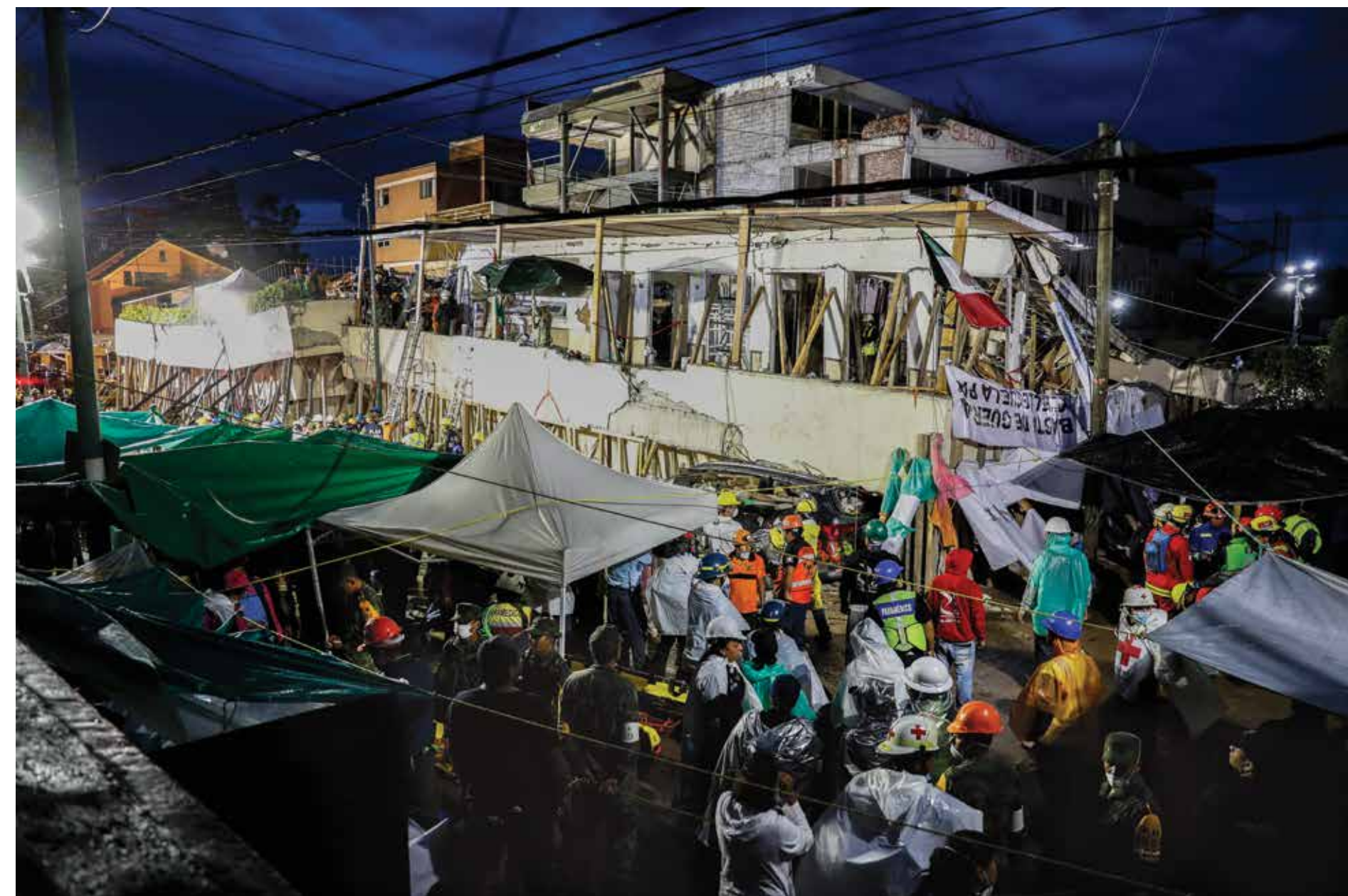
Elementos de la sociedad civil y de las autoridades durante los trabajos de rescate en el edificio del Colegio Rébsamen, una de las construcciones en las que hubo más víctimas. Colonia Nueva Oriental Coapa, 20 de septiembre de 2017. Foto: Christopher Roger Blanquet / El Universal .
