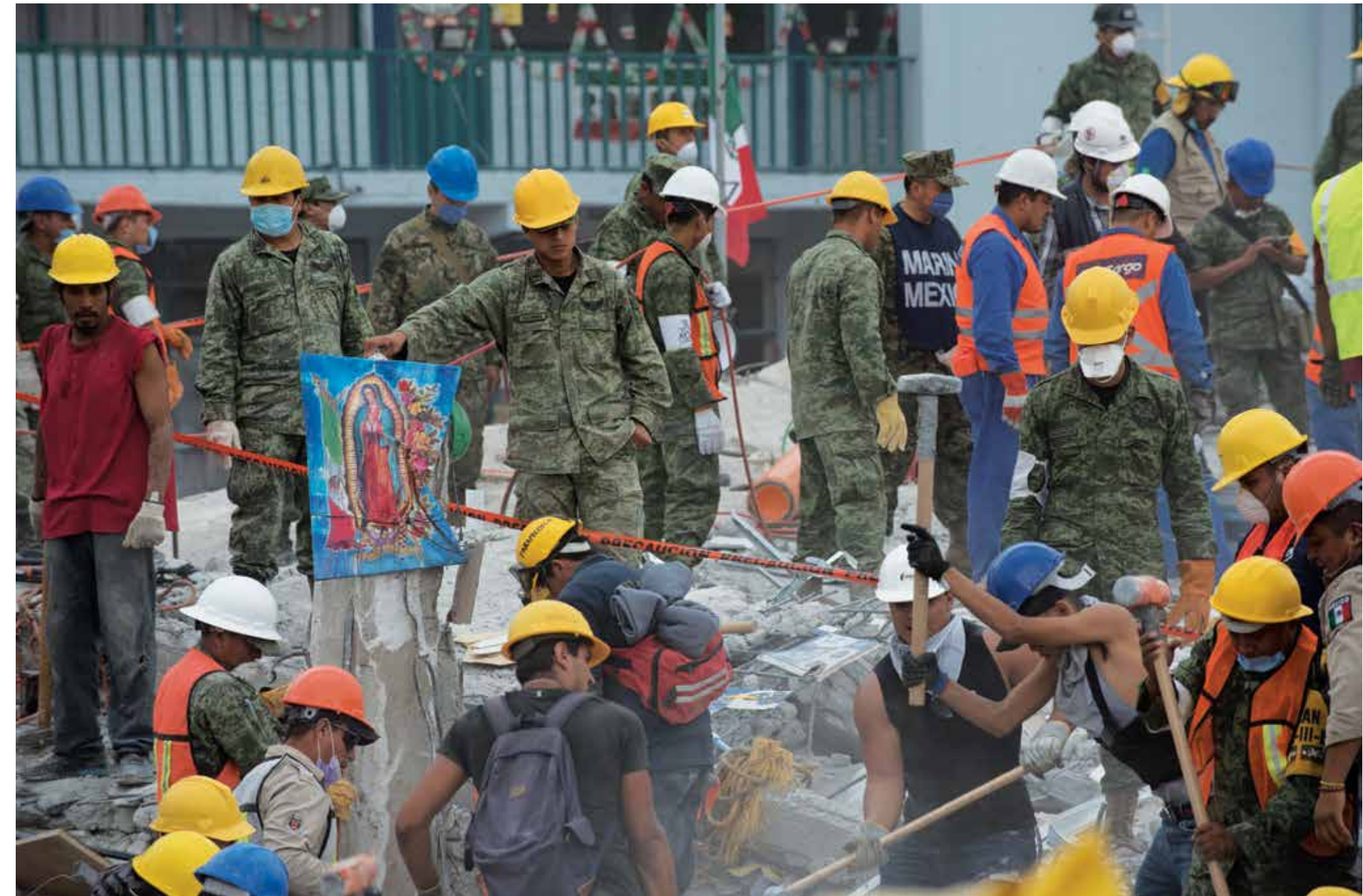
Entre el caos de la multitud que se encarga de retirar el cascajo, alguien colocó la imagen de la virgen de Guadalupe en una pequeña columna que se mantiene en pie. Colonia Obrera, Ciudad de México, 21 de septiembre de 2017. Foto: Arturo Lara Ramírez.
