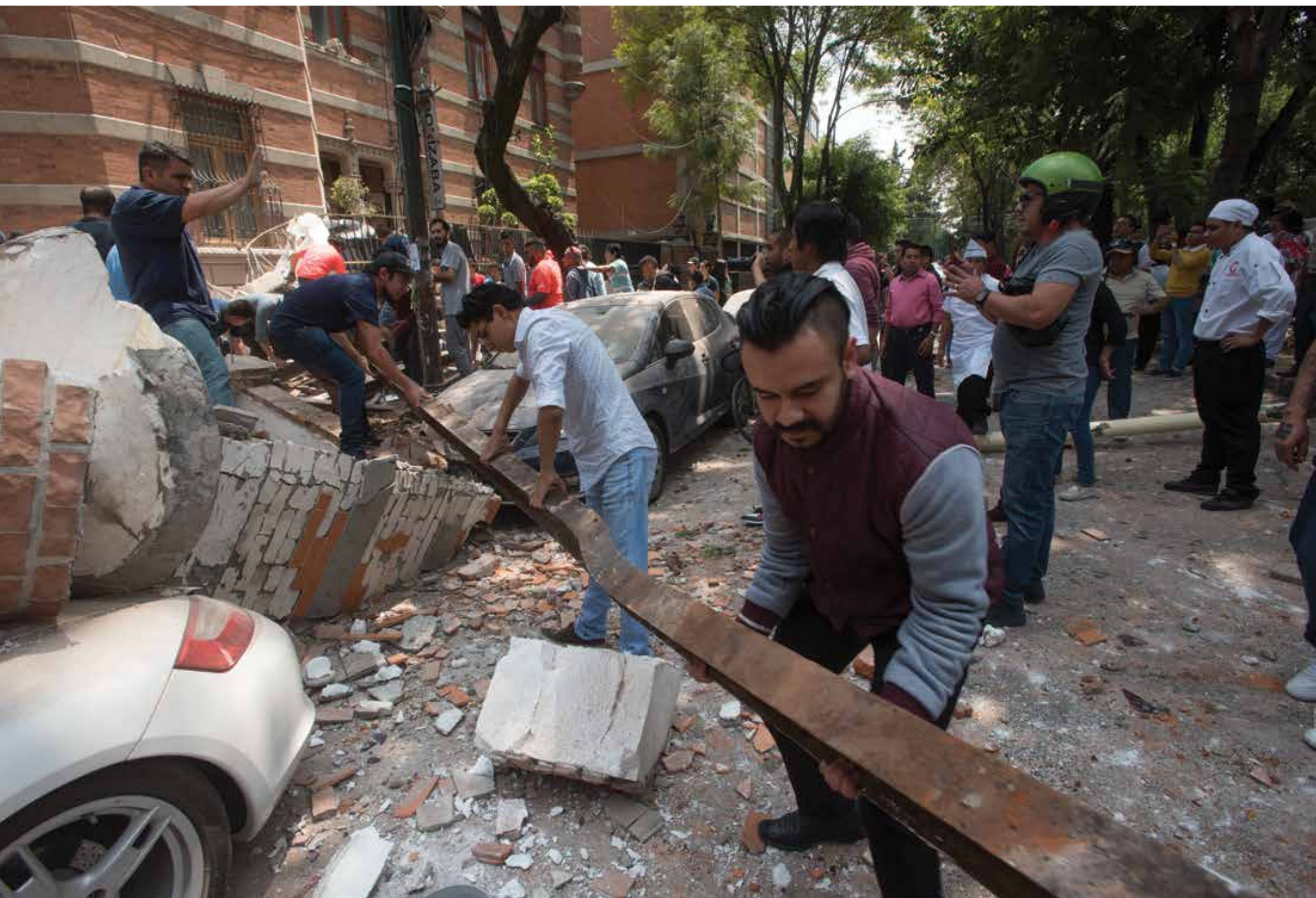
Torre de una escuela colapsada sobre una banqueta y un auto. La gente levanta los escombros por si alguien hubiera quedado atrapado. Colonia Roma, Ciudad de México, 19 de septiembre de 2017. Foto: Arturo Lara Ramírez.
