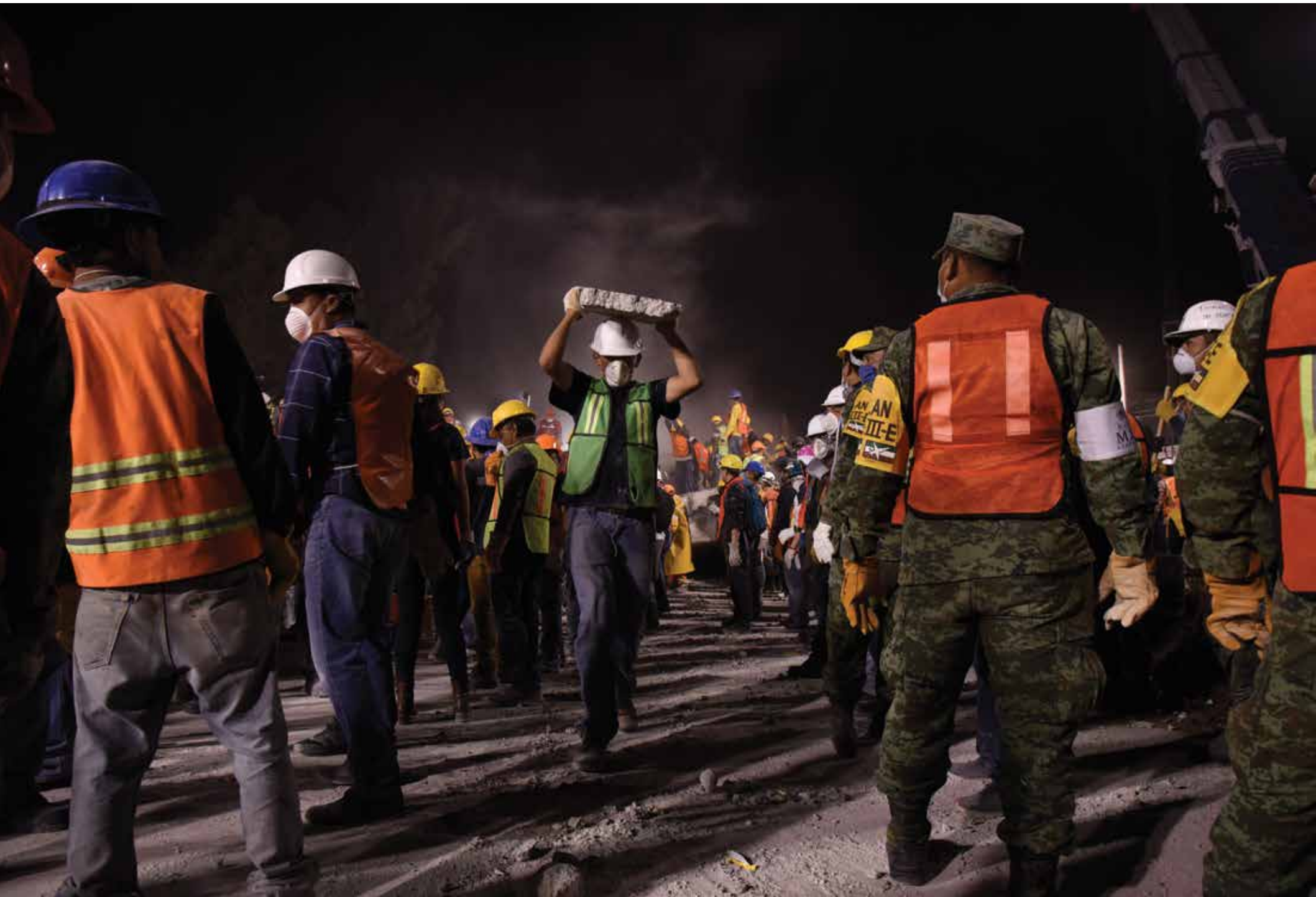
Un voluntario de la sociedad civil carga un bloque de concreto mientras elementos del Ejército y otros voluntarios sacan escombros de la zona afectada. Colonia Obrera, Ciudad de México, 21 de septiembre de 2017. Foto: Israel Fuguemann.
