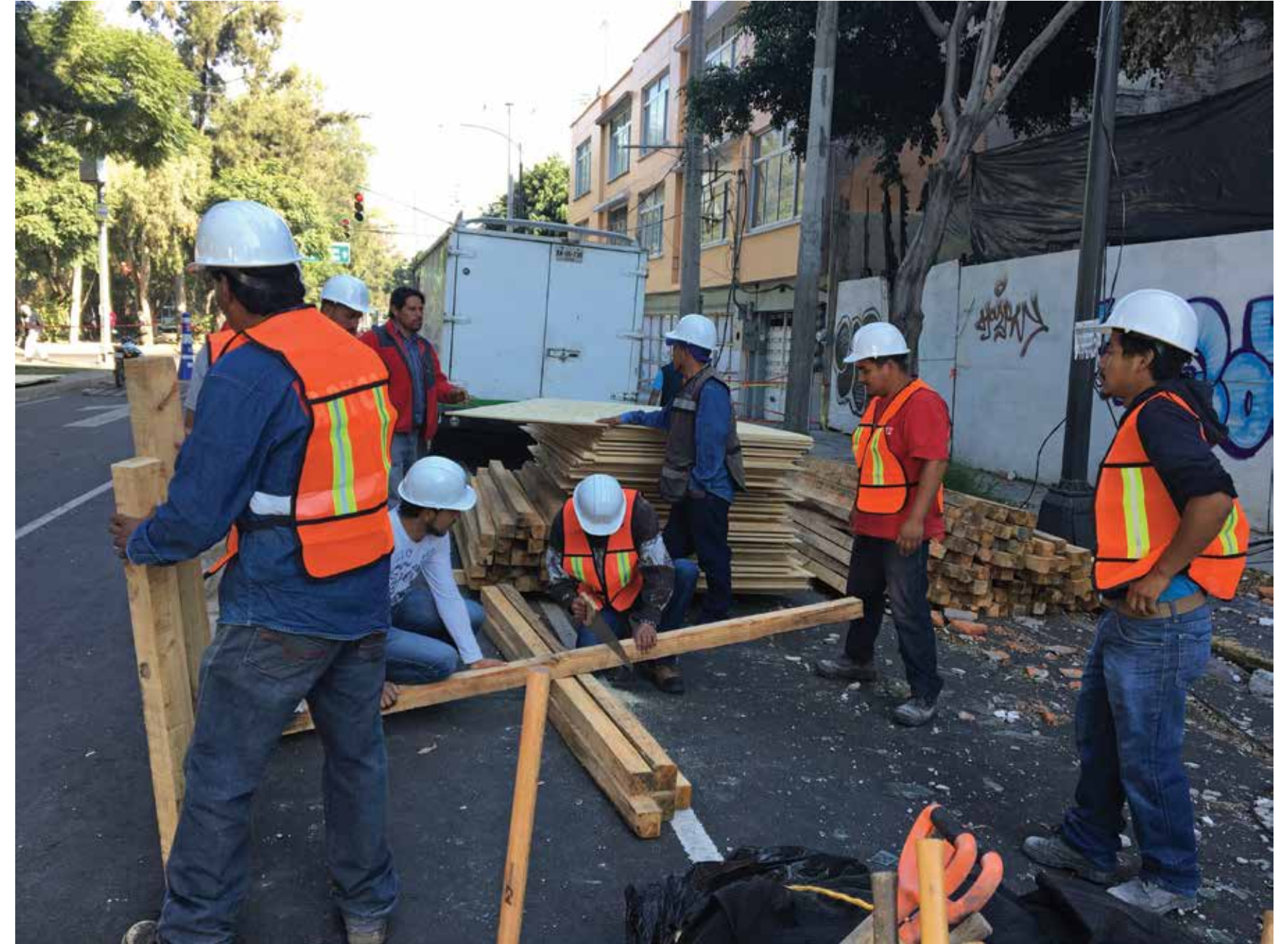
Trabajos de apuntalamiento en edificios parcialmente colapsados. Foto: Colección del Senado de la República.
