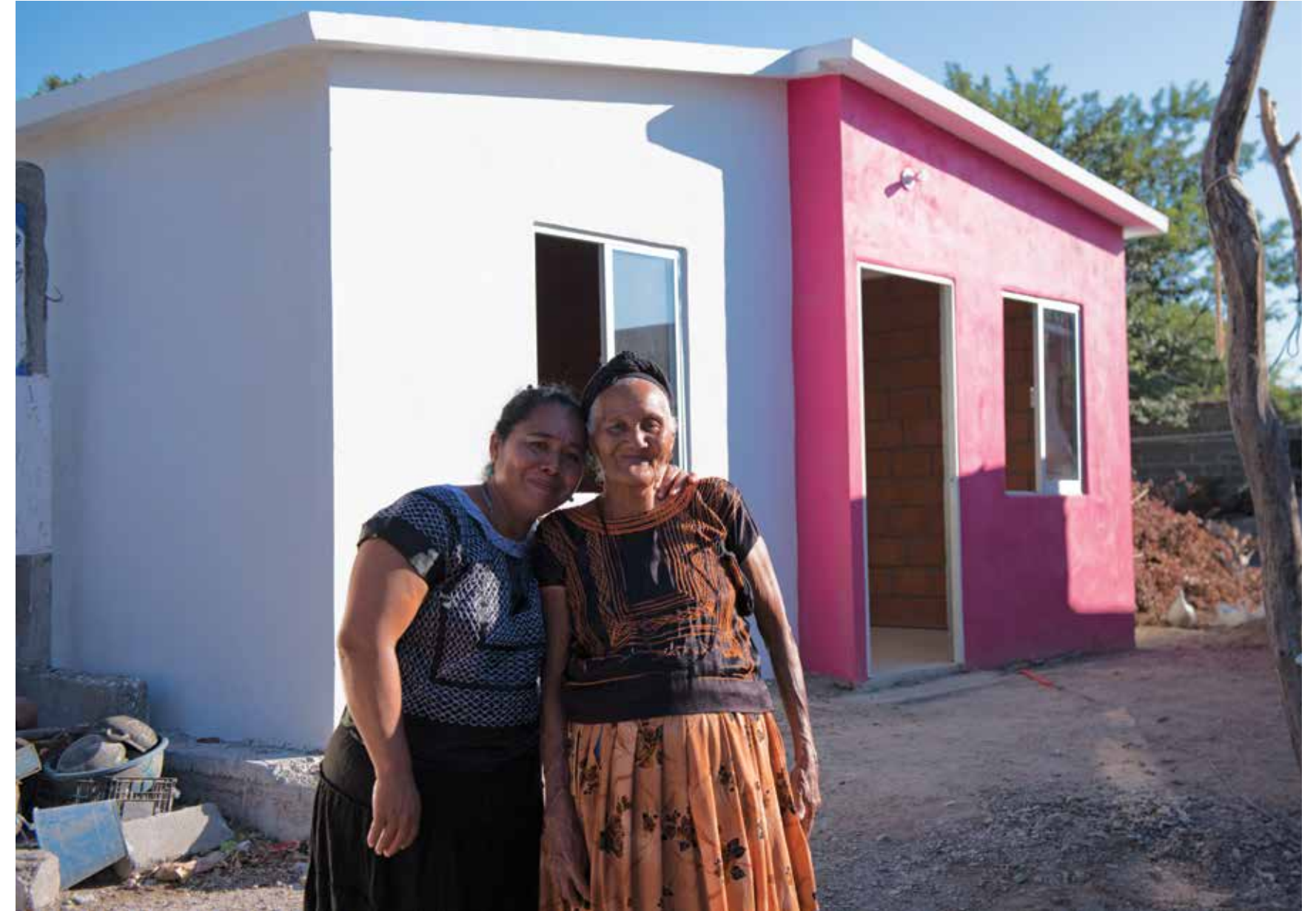
Con el mecanismo de autoconstrucción asistida, del Gobierno de la República, se reconstruyen viviendas afectadas por los sismos del 7 y el 19 de septiembre de 2017 en Chiapas. Foto: SEDATU Chiapas.
