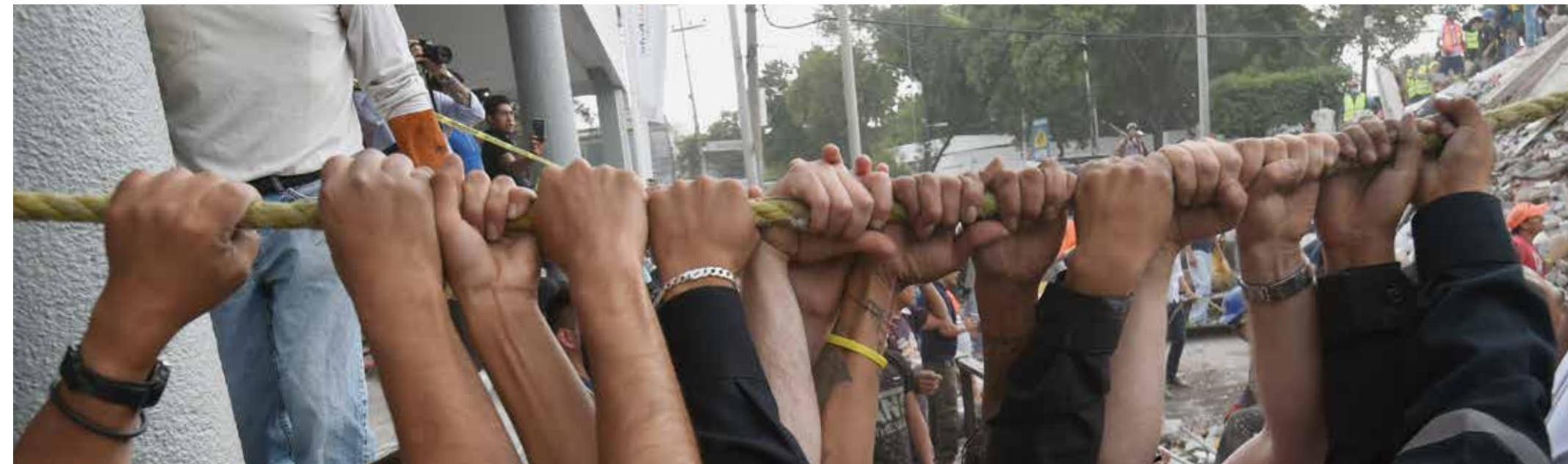
Hombres jalan una cuerda para retirar una losa de concreto y continuar la búsqueda de sobrevivientes en las calles de Petén y Zapata. Colonia Emperadores, Ciudad de México, 19 de septiembre de 2017. Foto: Alex González.
