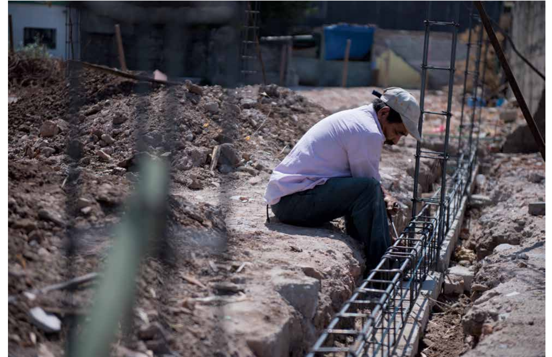
Con el mecanismo de autoconstrucción asistida, del Gobierno de la República, se reconstruyen viviendas afectadas por los sismos del 7 y el 19 de septiembre de 2017 en Chiapas. Foto: SEDATU Chiapas.
