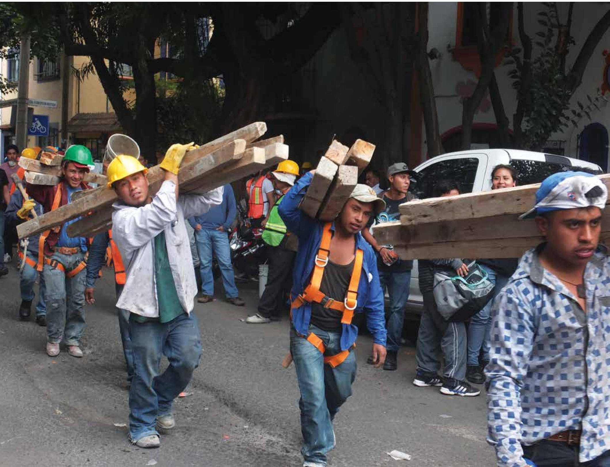
Trabajadores de la construcción llevan polines para ayudar a sostener estructuras en riesgo de colapso y disminuir el peligro para los rescatistas y los voluntarios. Colonia Del Valle, Ciudad de México, 20 de septiembre de 2017. Foto: Pablo Gustavo Inclán Solís.
