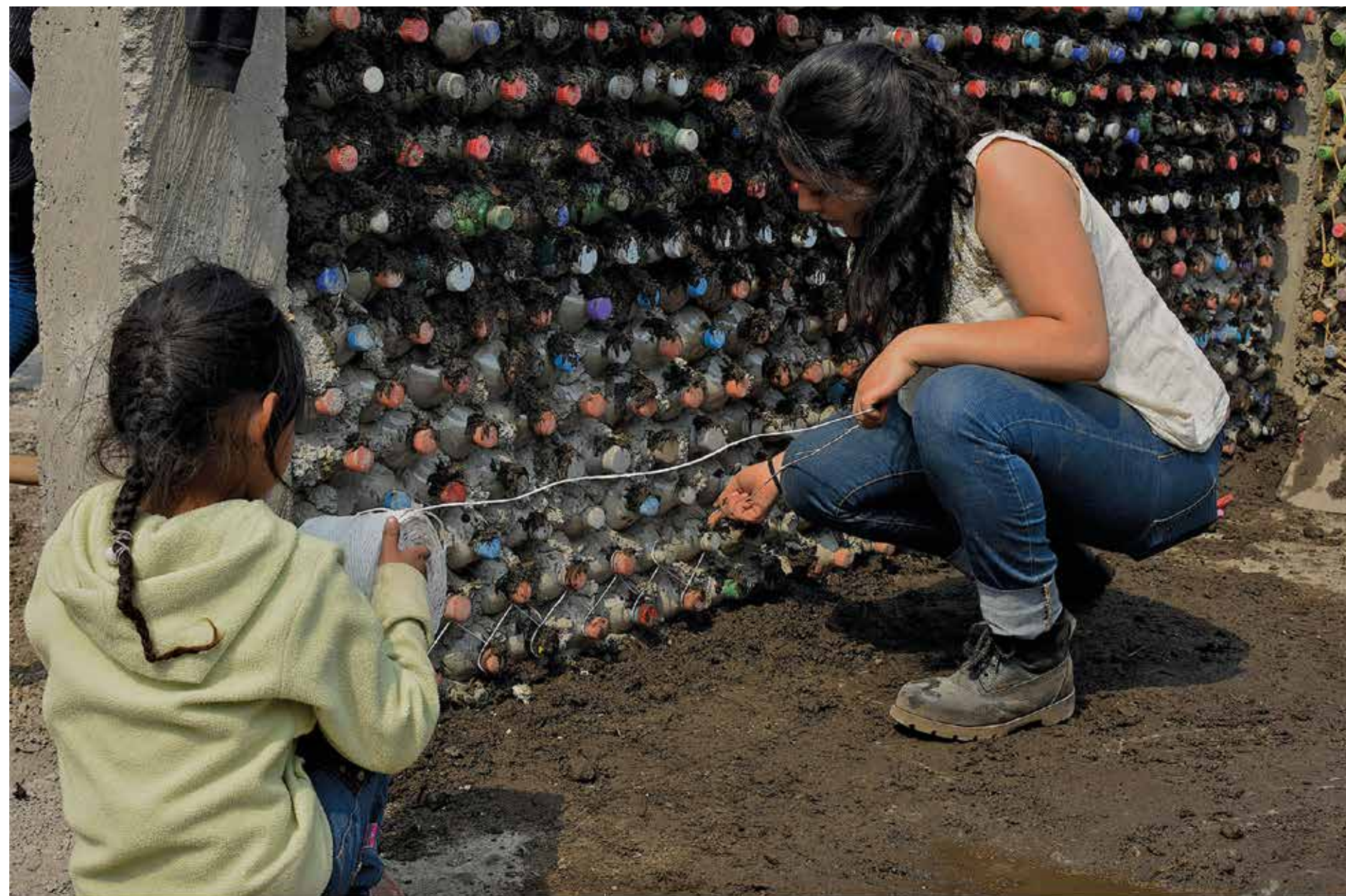
Atado de botellas con rafia. Ocuilan, Estado de México, 24 de febrero de 2018. Foto: Dafne Karina Gallardo Aceves / VIEM MX .
