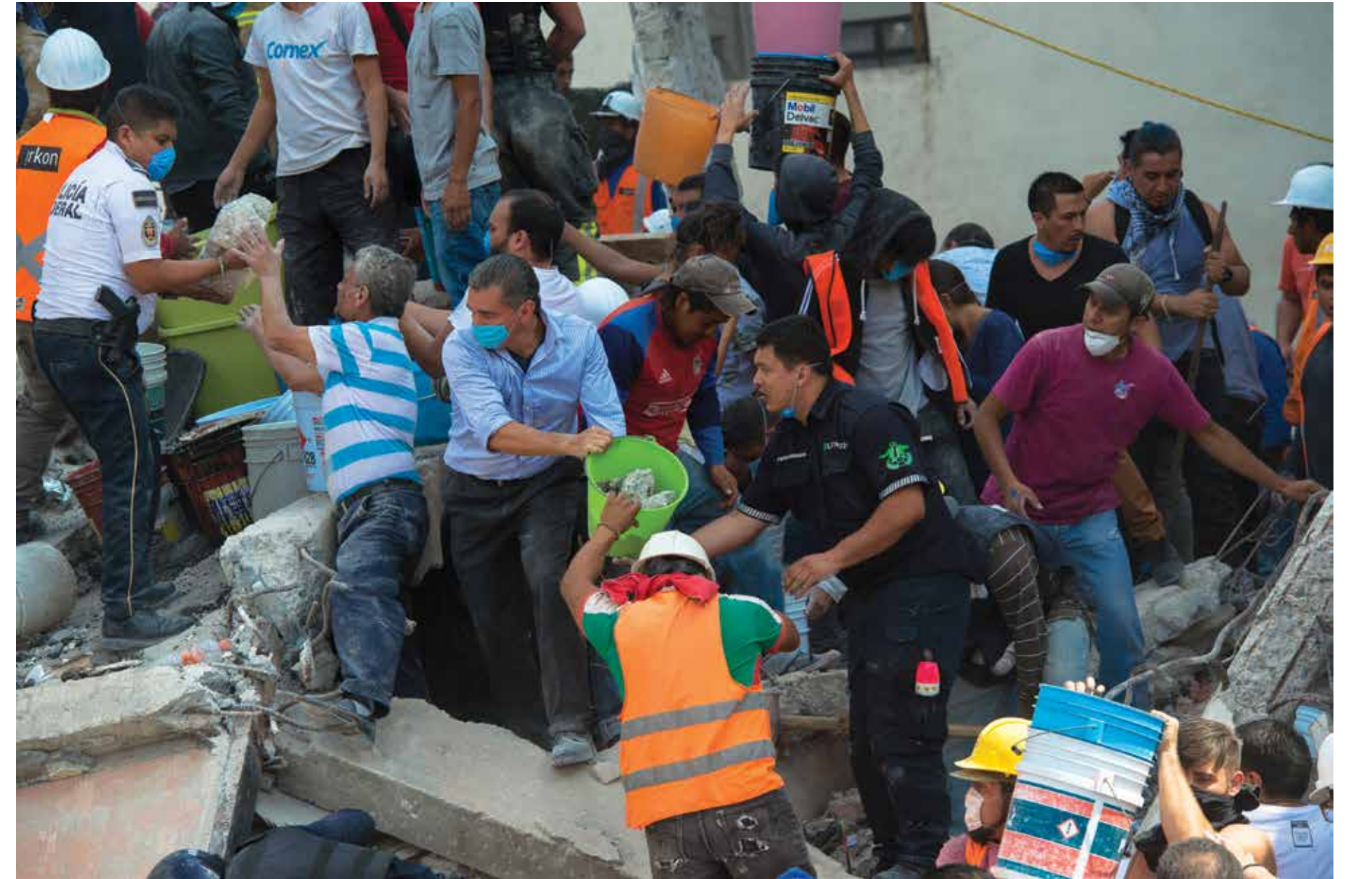
Ciudadanos retiran escombros con cubetas y herramientas prestadas de las construcciones cercanas para tratar de rescatar a las personas atrapadas en un edificio colapsado en la esquina del Viaducto y la calle de Torreón. Colonia Piedad Narvarte, Ciudad de México, 19 de septiembre de 2017. Foto: Nicolás Tavira.
