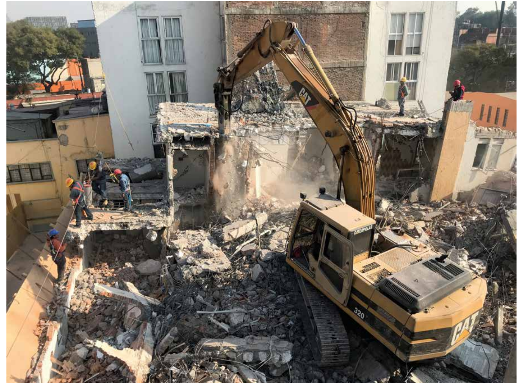
Retiro de escombros con maquinaria pesada. Foto: Colección del Senado de la República.
