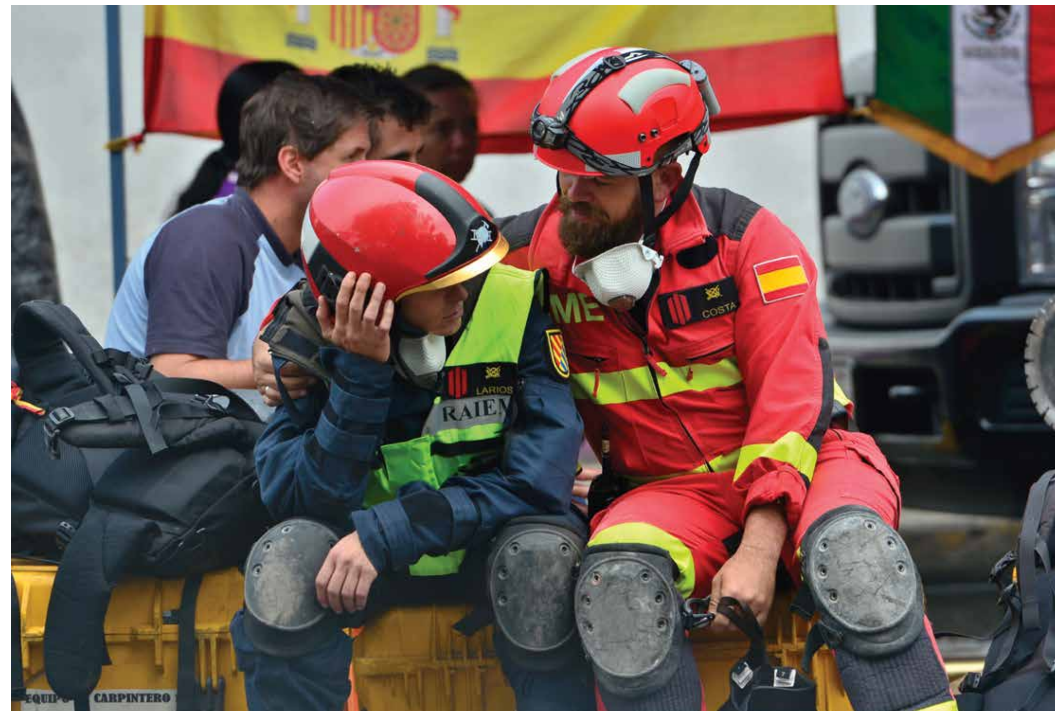
Rescatista español abraza a su colega para darle ánimo después de horas de intenso trabajo en las labores de búsqueda y rescate entre los escombros de un edificio colapsado en la avenida Álvaro Obregón. Colonia Roma, Ciudad de México, 25 de septiembre de 2017. Foto: Nicolás Tavira.
